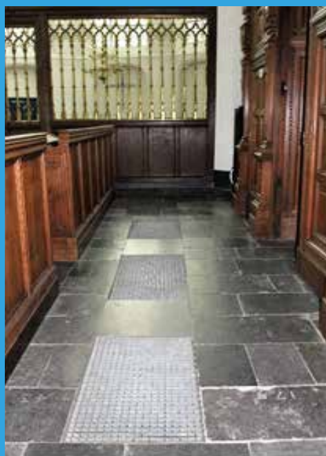
Verwarmingsplaten in de vloer. Vloerverwarmingsroosters
