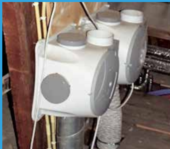
Mechanische afzuigunits.
